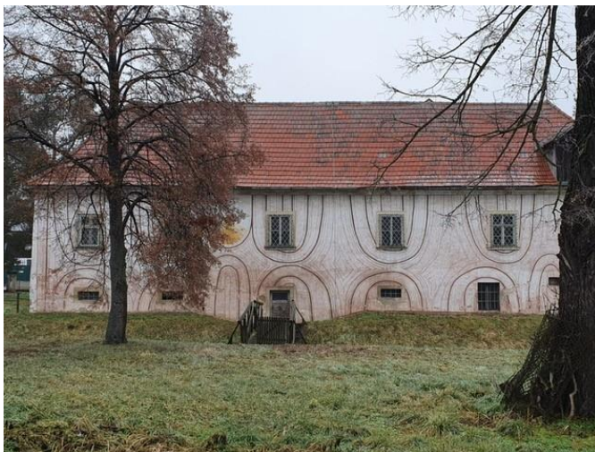
Abbildung 12: Fassade Schloss Lengenfeld
