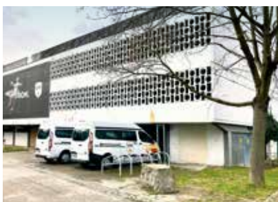
Das ehemalige Garderobengebäude des Freibades (kleines Bild oben), das direkt an die Sporthalle angrenzt, wird abgerissen.
